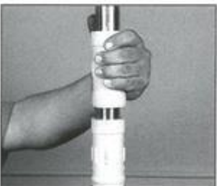
4.27e Wenn kein solches Spezialwerkzeug zur Hand ist, kann man den Ring auch mit passenden Kunststoffrohren (Abwasserrohr) eintreiben. Das obere Rohr wird als Schlagwerkzeug eingesetzt.
