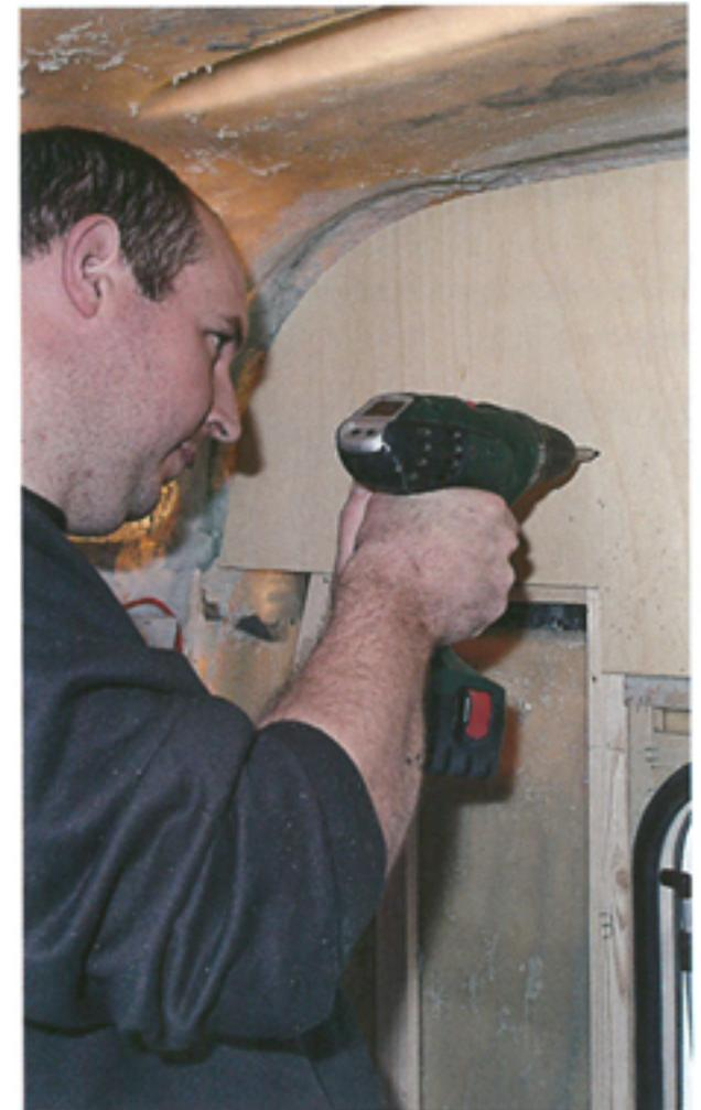
**3** Wie die Teile eines Puzzles sägen wir aus 6 mm dickem Sperrholz die Paneele aus und kleben und schrauben sie an der richtigen Stelle fest. Alle Schraubenköpfe werden sorgfältig versenkt.
