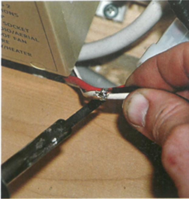
**5** Die negative Verbindung der Steckdose wird hergestellt, indem wir das abisolierte Ende mit einem genügend dicken, passenden Kabel verlöten. Die Stelle wird dann mit Isolierband geschützt.
