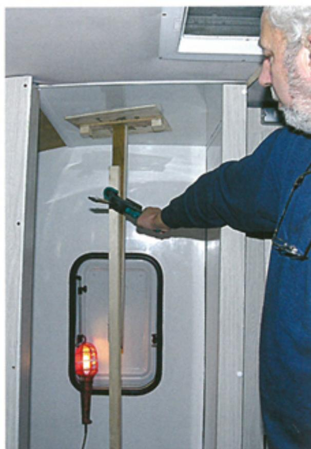
**8** Natürlich funktioniert ein solcher Polyurethankleber nicht wie ein Kontaktkleber. Während des Aushärtens muss das Stück an Ort und Stelle gehalten werden. Mit einer Zwinde verbinde ich dazu zwei Holzleisten.
