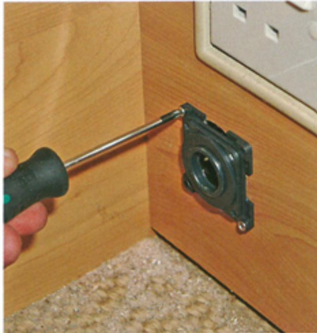
**8** Als Nächstes führen wir die Steckdose in das Loch im Garderobenpaneel ein und befestigen sie mit zwei kurzen selbstschneidenden Schrauben. Zuvor bohrten wir aber kleine Löcher vor, um Risse zu vermeiden.
