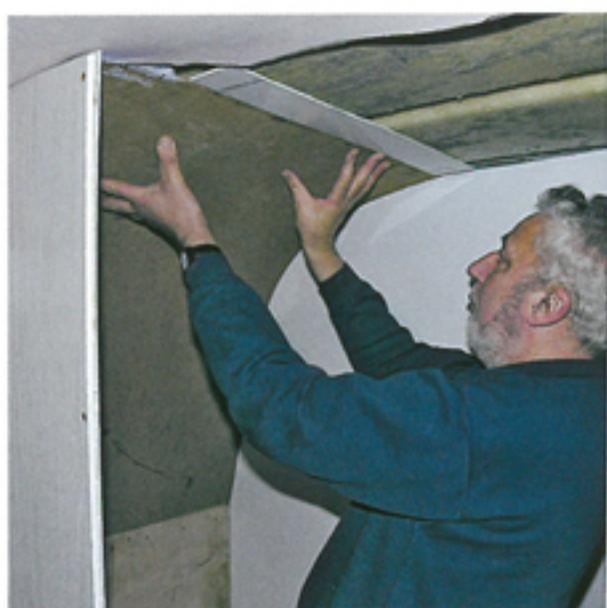
**6** Dann kleide ich die Decke mit Hartfaserplatte aus, weil sie biegsam ist und der Linie des Daches folgt. Wo immer es geht, verschraube ich die Platte. Ansonsten verwende ich Klebt + Dichtet von Würth.
