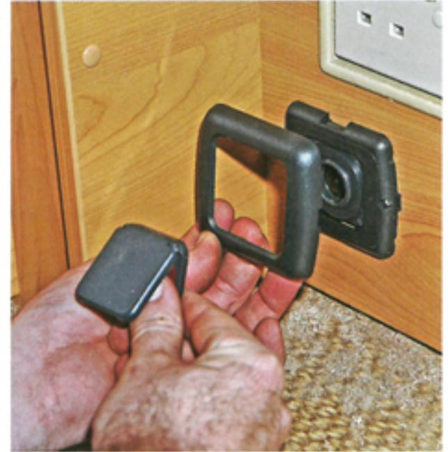
**10** Beide Komponenten rasten an Ort und Stelle ein. Der Abdeckrahmen passt in Schlitze des inneren Rahmens und der Klappdeckel wird von Zapfen festgehalten.
