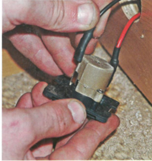
**7** So sieht die Rückseite der Steckdose aus. Die Flachstecker werden mit Schrumpfschlauch elektrisch isoliert.
