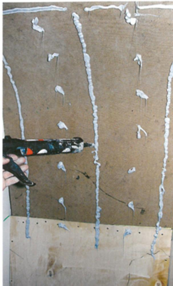
**7** Mit demselben Polyurethankleber verklebe ich auch Holzleisten, Proclad und andere Verkleidungen an Ort und Stelle. Wenn Sie bei kaltem Wetter arbeiten, sollten Sie die Kartusche zuerst erwärmen.
