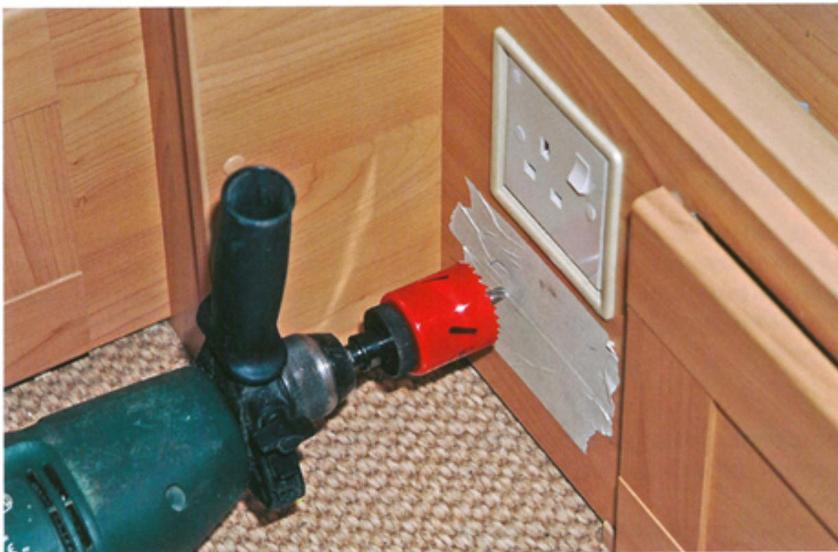
**2** Wir verwenden einen Lochschneider in unserer Bohrmaschine und schneiden damit ein Loch in die Garderobe, groß genug, um die vorstehenden Teile auf der Rückseite der Steckdose aufzunehmen.
