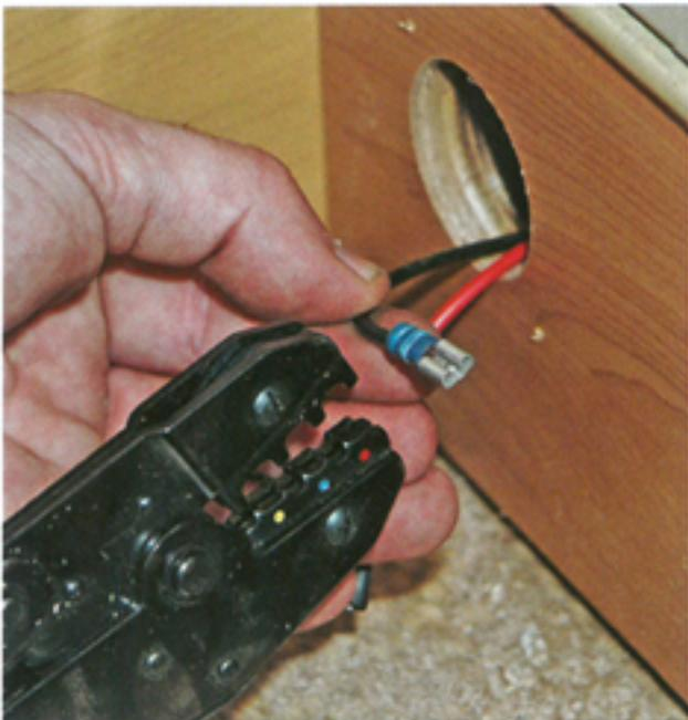
**6** Die steckdosenseitigen Enden der Kabel bekommen Flachstecker, die in manchen Kits enthalten sind. Sie werden mit einer Crimpzange an den abisolierten Kabelenden befestigt.
